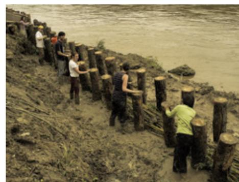
▲ Entre deux rangées de poteaux de Pins jointifs enfoncés profondément, des fascines de rameaux de saules fixent les vases qui se déposent et les stabilisent, assurant un soutien de la terrasse complantée de végétaux fixés par une résille végétale.
